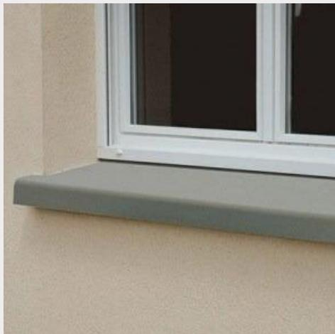
Figura 1- Peitoril embutido 1 cm na alvenaria
