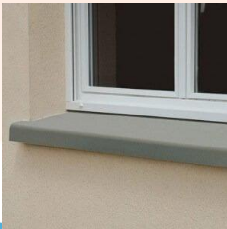
Figura 1- Peitoril embutido 1 cm na alvenaria
