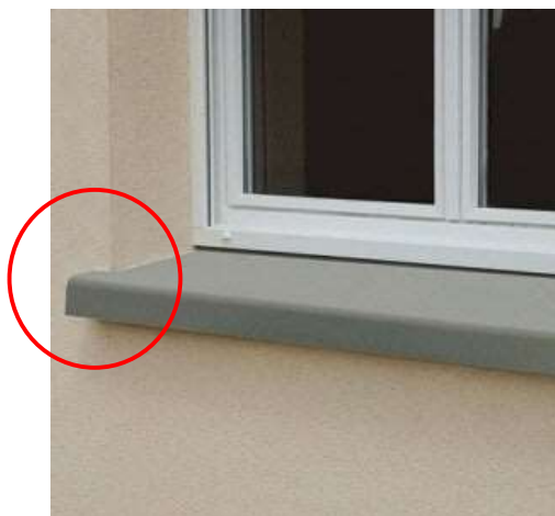
Figura 2- Peitoril embutido 1 cm na alvenaria
