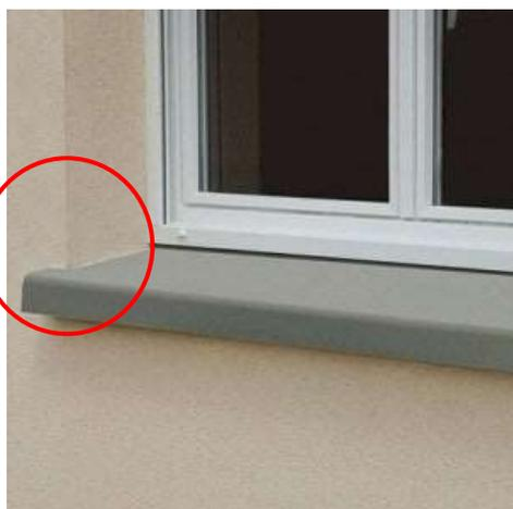
Figura 3- Peitoril embutido 1 cm na alvenaria
