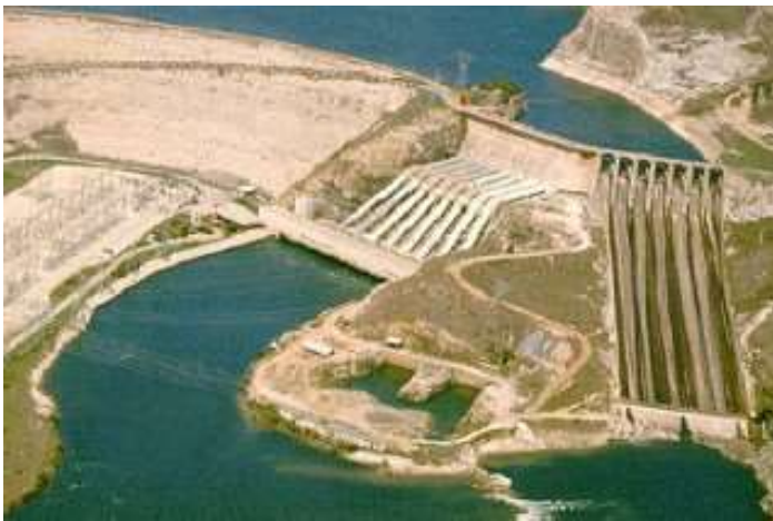
Construção de barragem hidrográfica.
